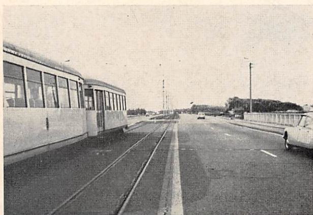
Les voies vicinales, au littoral, sont séparées du trafic routier dans une proportion de 75 % entre Ostende et La Panne et de 80 % entre Ostende et Knokke.
