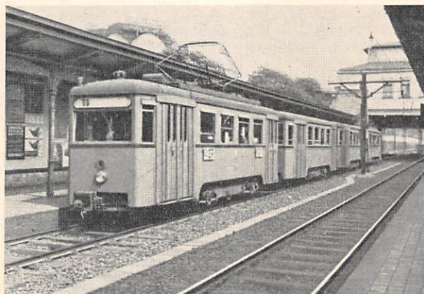
Il s'agit ici du « Stadtbahn » de Vienne, chemin de fer de ceinture, transformé en « semi-métro » en 1925. Mais c'est aussi un pré-métro, car il sera incorporé au métro lourd en construction actuellement.
