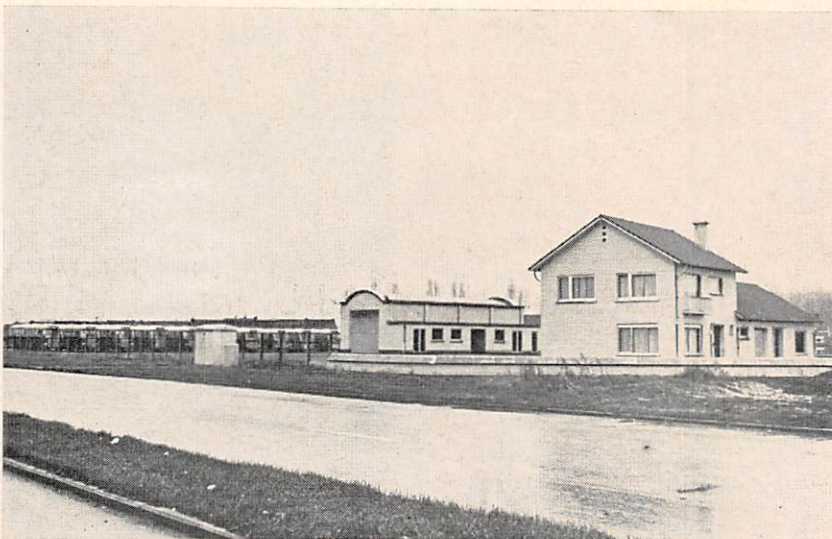
L'aspect des bâtiments vus de la nouvelle route.
