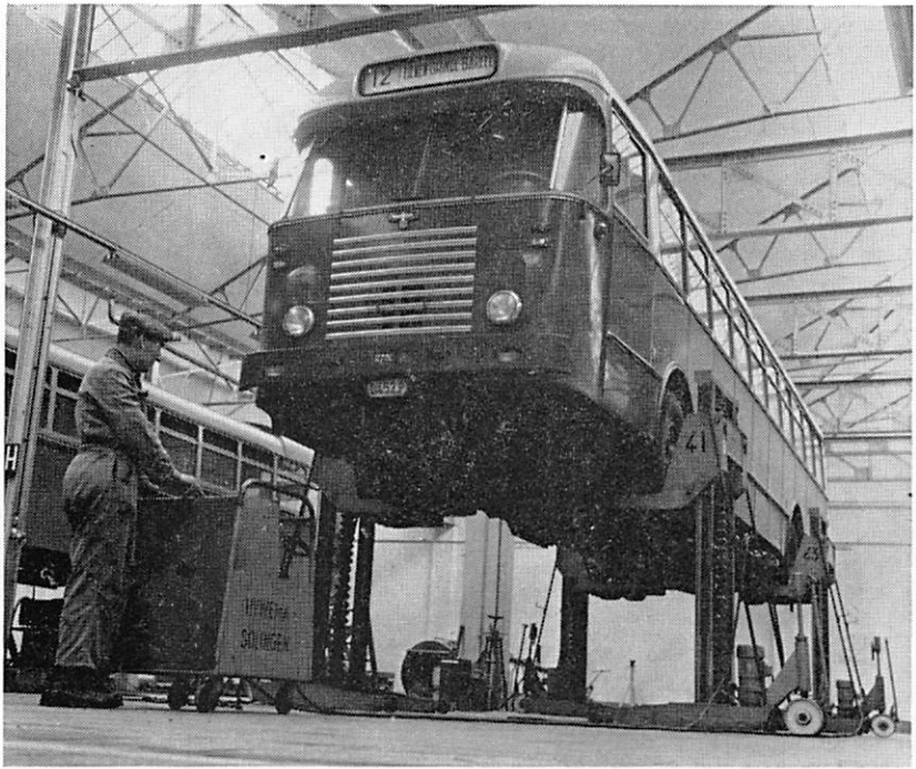
Quatre élévateurs mobiles soulevant un autobus.
