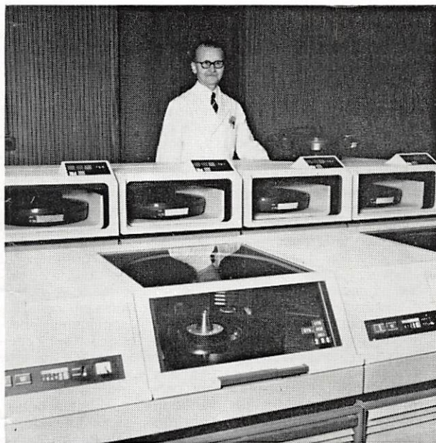
M. Steux, opérateur, et des armoires à disques magnétiques. Les quatre disques à l'arrière-plan, quoique de dimensions réduites, ont chacun une capacité dix fois supérieure à celle du disque se trouvant au premier plan.
