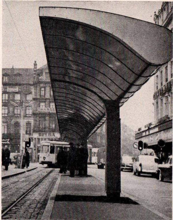
exigences du gabarit de nos voitures. L'établissement d'une paroi longitudinale aurait réduit de façon notable la largeur utile du quai, déjà insuffisante aux heures d'affluence. Il ne pouvait, en effet, être question d'implanter une cloison sans réserver entre celle-ci et la chaussée une zone de sécurité suffisante.
