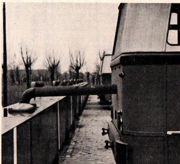
Un tuyau coudé partant de la canalisation principale est introduit dans le coffre du moteur.
