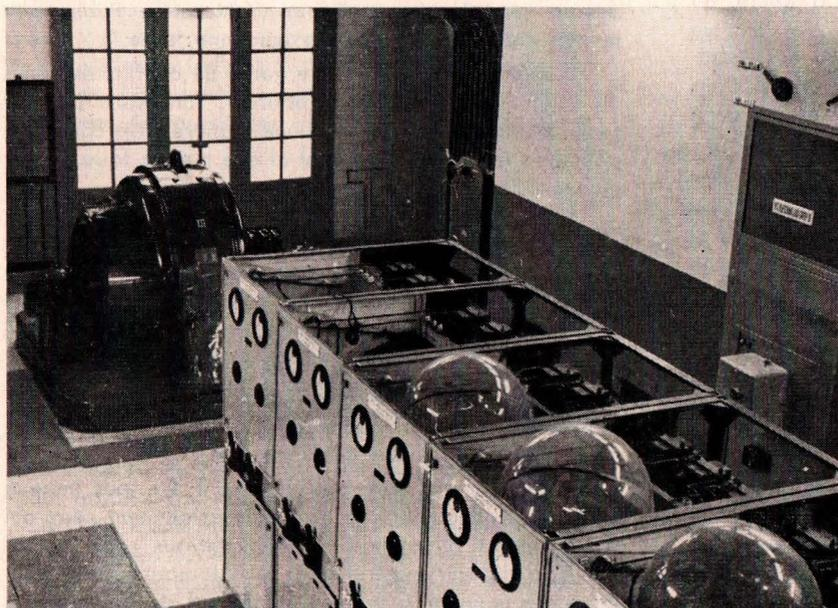
A l'avant-plan, les armoires d'ampoules où deux d'entre elles doivent encore être placées. Devant la porte, l'ancienne commutatrice de 1000 kw. qui sera maintenue comme réserve jusqu'à nouvel ordre.
