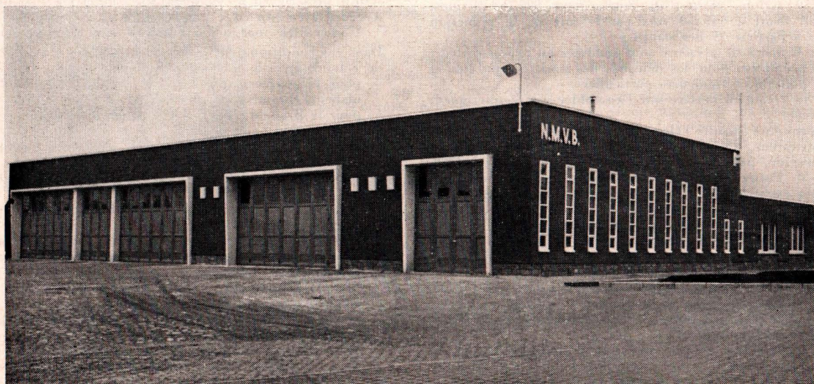
Garage pour autobus au dépôt de Saint-Trond.
