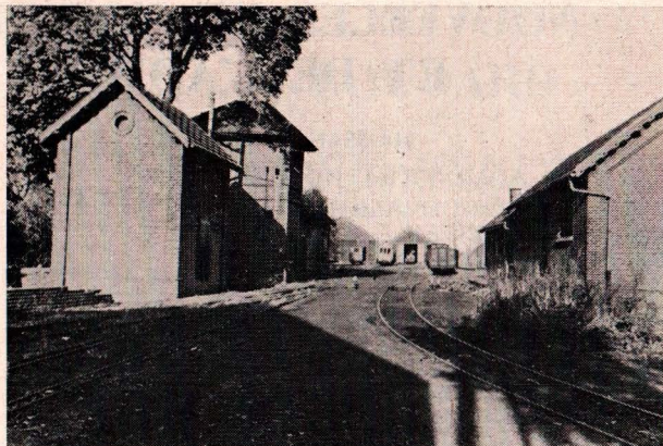
Entrée des installations de la gare vicinale de Schepdaal; il y a 150 m. de voie jusqu'aux remises 2 et 3 du musée. Le bâtiment de droite servira de salle de réunion et de conférence et sera équipée pour la projection de films et de diapos.
