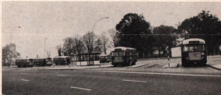
Vue générale de la nouvelle station d'autobus d'Oostmalle. A l'avant-plan, la route macadamisée Anvers-Turnhout.
