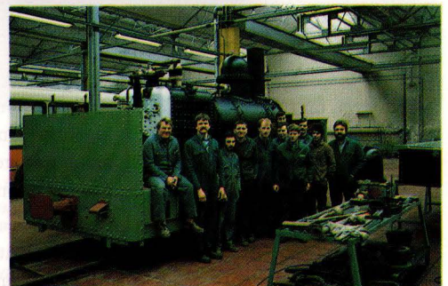
Werkplaats Kessel-Lo : de agenten en hun locomotief tijdens de restauratie.
