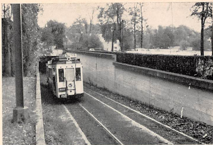
A LA SORTIE DU TUNNEL DU GROS-TILLEUL, TRAIN DE LA LIGNE « L » SE DIRIGEANT VERS MEISE (Photo R. Bastaens)
