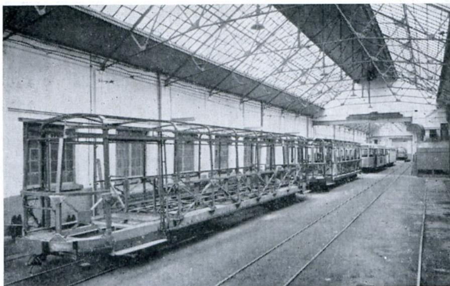
Construction d'une caisse de voiture métallique (Atelier de Cureghem).
