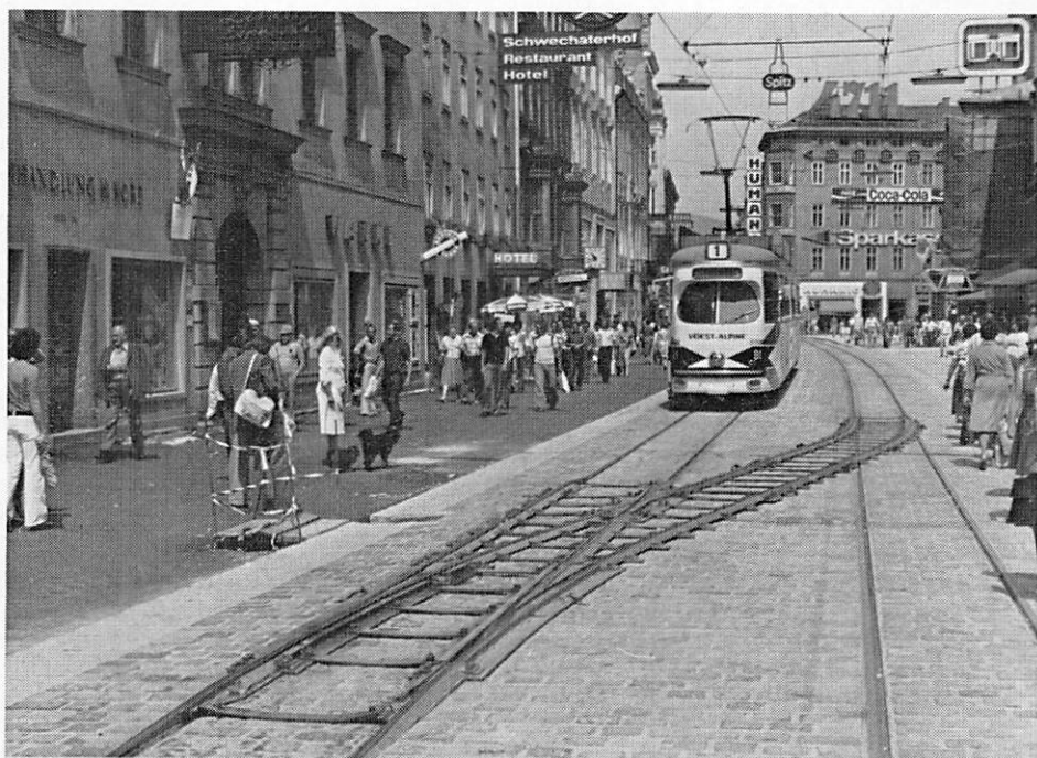
Aiguillage mobile à Linz (Photo W. Hoste le 9/7/77) Vliegende wissel te Linz (Foto W. Hoste 9/7/77)
