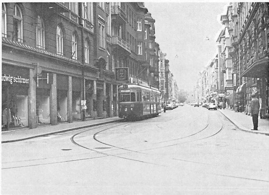
Croisement en ciseaux à l'Anichstrasse à Innsbruck. Une des motrices récemment acquises à Hagen s'apprête à pénétrer dans la Maria Theresienstrasse (Photo W. Hoste, le 17/7/77) Kruising in schaar aan de Anichstrasse te Innsbruck. Een van de zopas te Hagen aangeschafte motorwagens gaat de Maria Theresienstrasse inrijden (Foto W. Hoste 17/7/77)
