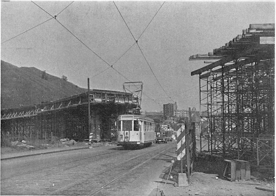
Dampremy (Pont du Canal) : travaux en cours et motrice 1 Agent vers Anderlues (Photo J. Delporte)
