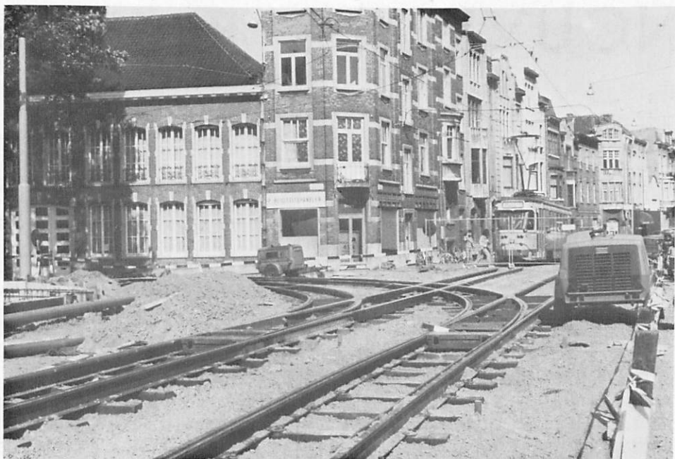
Travaux de voies en cours d'achèvement sur le Rozemarijnbrug (Photo W. Hoste 20.8.80)
