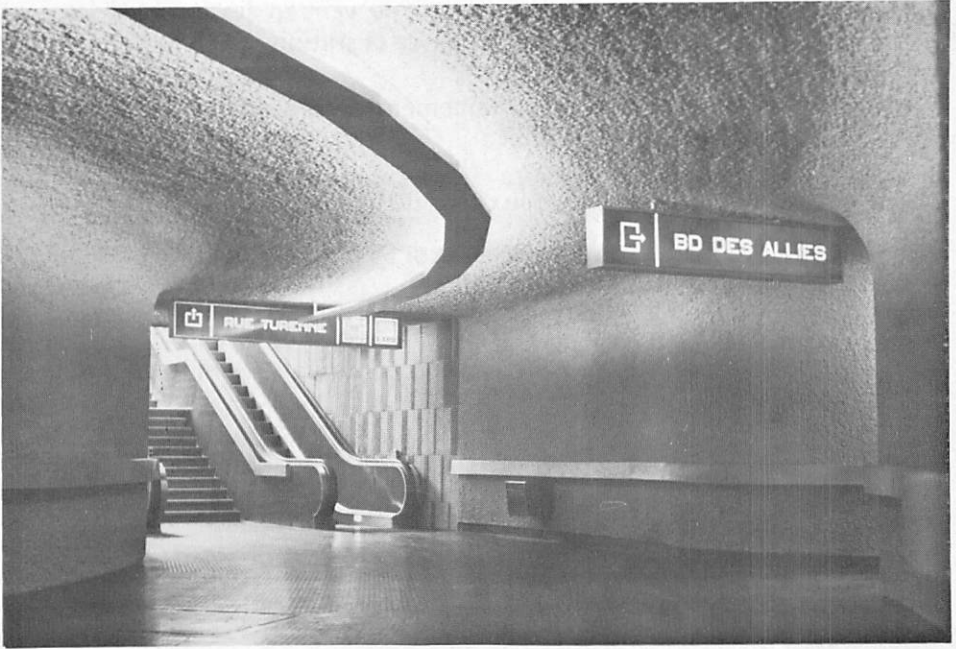
Station Ouest : couloir d'accès vers les sorties rue Turenne et Bd. des Alliés (Photo J. Delporte)
