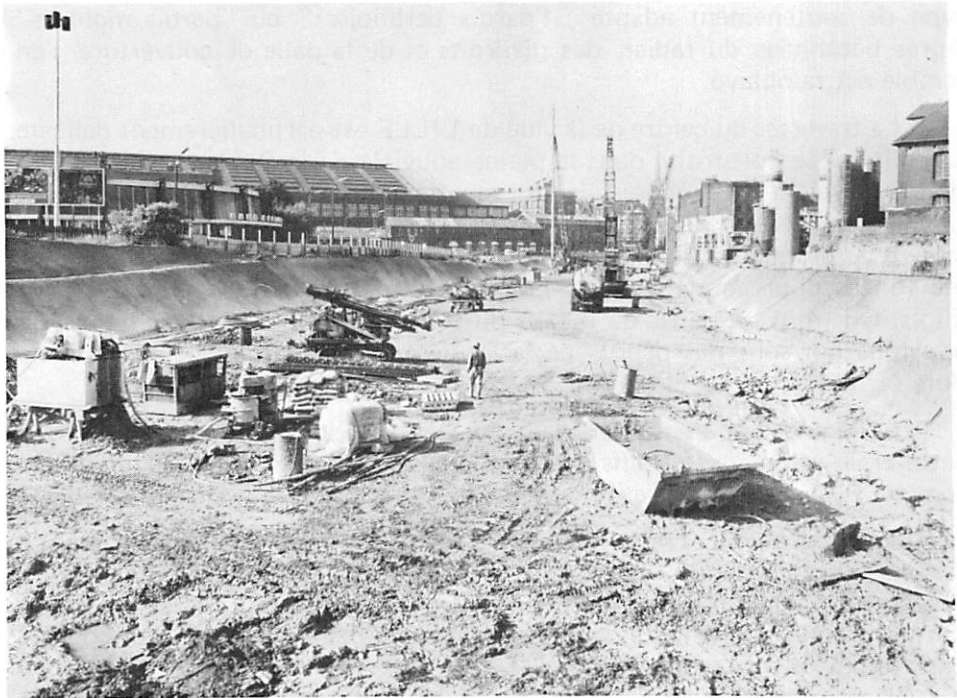
Travaux du métro à proximité des gares SNCF et routière (Photo P. WALET).
