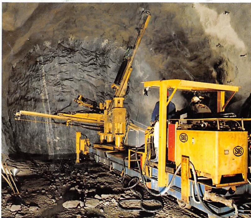
*Le percement du tunnel de la Furka fut un travail colossal, ci-contre un «Jumbo» de perforation utilisé pour le boulonnage des parois côté Oberwald, ci-dessous la section à double voie pour croisement située au Km 3,697 vue durant le chantier. (Documents F.O.)*
