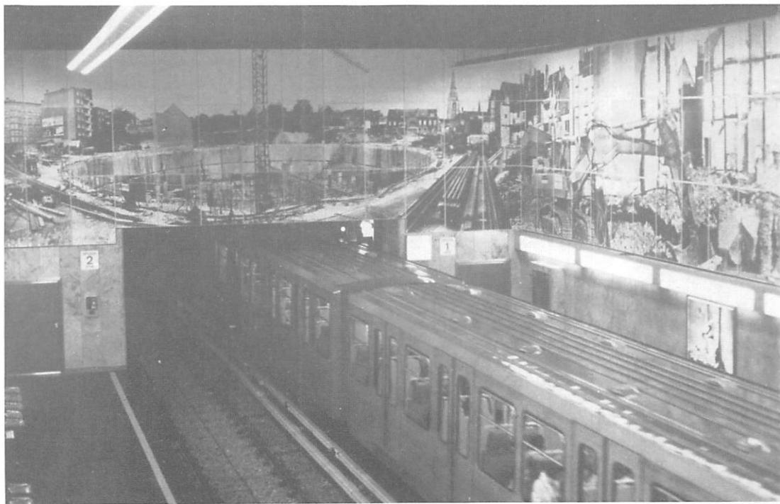
STATION AUMALE (5 octobre 1982). Evocation photographique des travaux de fondation de la station Saint-Guidon. (Photo P. Rinert)
