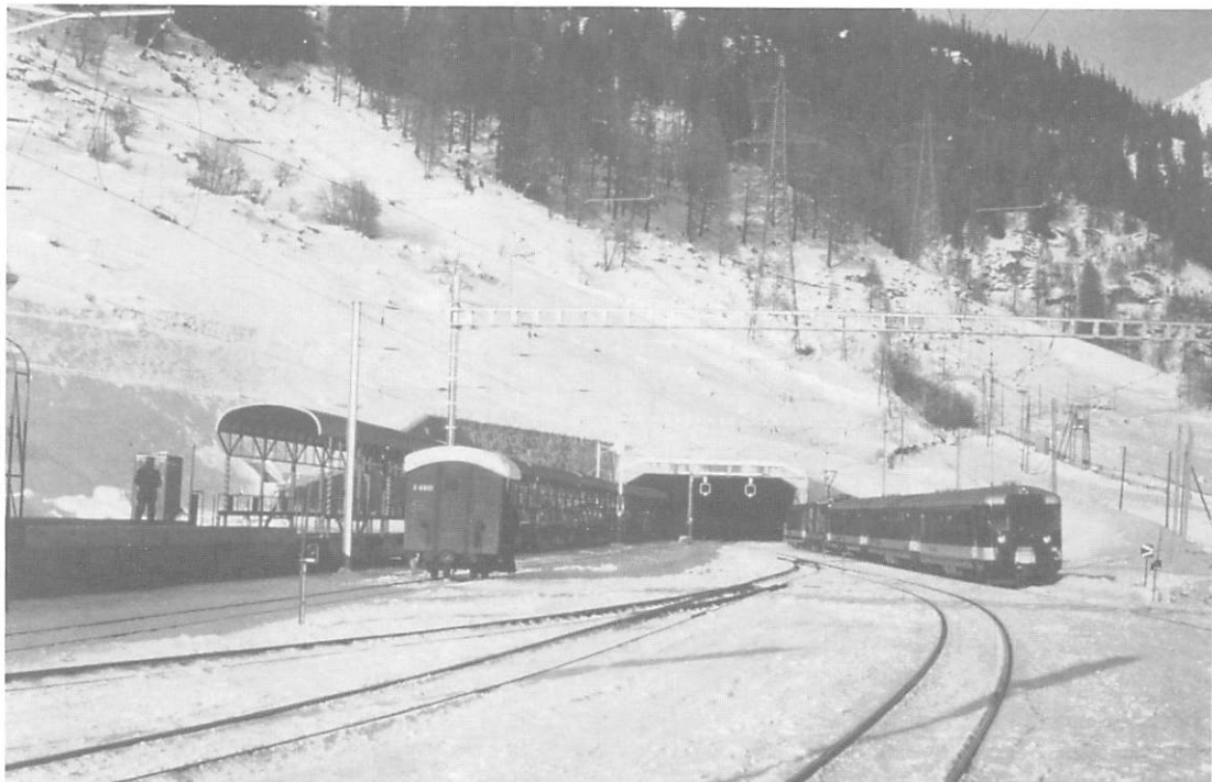
OBERWALD (décembre 1982). Le "Göschenen - Brigue" à la sortie du tunnel de contournement. (Photo R. Dieudonné)
