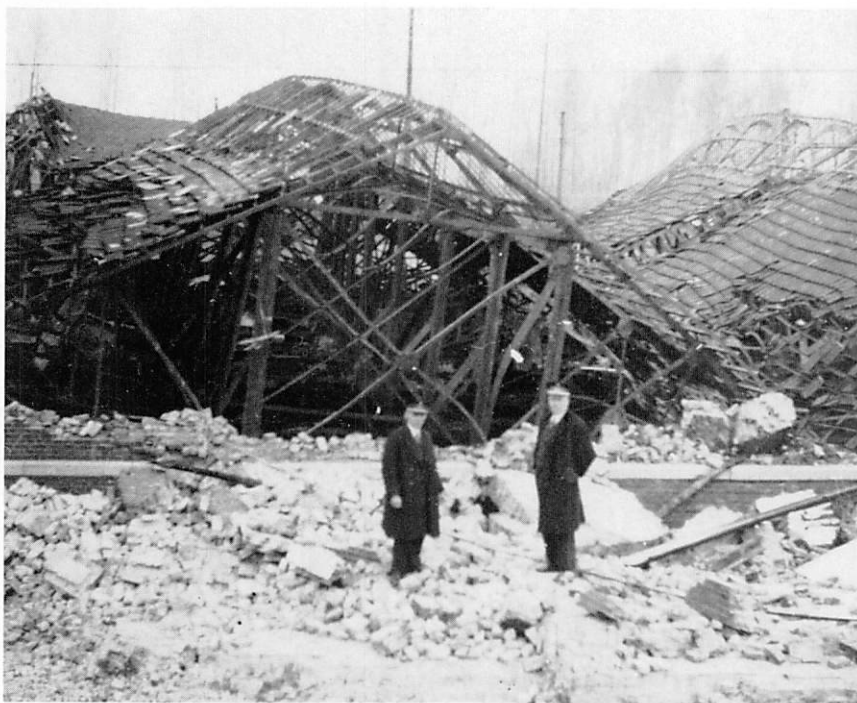
HAECHT (dépôt). Ruines des remises après la tragique nuit du 18 mars 1937. (Collection P. Dehon)
