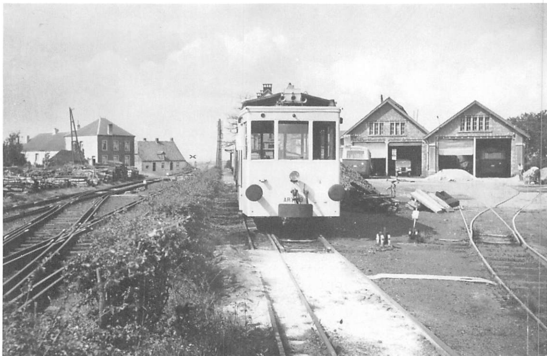
FORGES : ART. 89 et vue sur les voies à double file de rails en août 1957. (Photo P. Van Campenhoudt)
