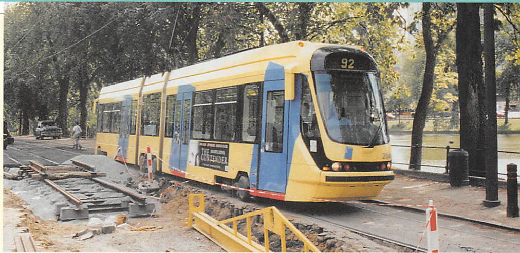
Het traject van de vroegere lijn 16, nu in- en uitrukroute van de stelplaats Elsene, wordt geheel vernieuwd. Hiertoe reden de trams op enkelspoor tussen de remise en het Flageyplein. 28 mei 2001. (foto René Stevens)
