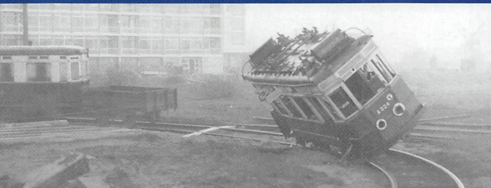
Hier wordt de A 324 in de lus achter de remise Leiden omvergetrokken om daarna in kleine stukjes te worden gehakt. Het koperwerk is zo te zien al uit de wagen verwijderd. De koplampen zijn eraf en de ventilatieraampjes hangen wijd open, dus de koperen handgrepen van deze raampjes zitten er niet meer in. De foto dateert van eind 1959. (Hans van Engelen)
