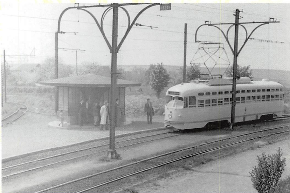
Boven. Vossem (Vier Winden). Hier was een splitsing, waarbij de oorspronkelijke lijn van Leuven verder liep naar Tervuren (spoor links op de foto). Rechts komt een PCC-wagen uit Brussel (er reden PCC's tussen Brussel en Leuven van 1951 tot 1953). (foto E. Roels, verz. Paul De Backer)
