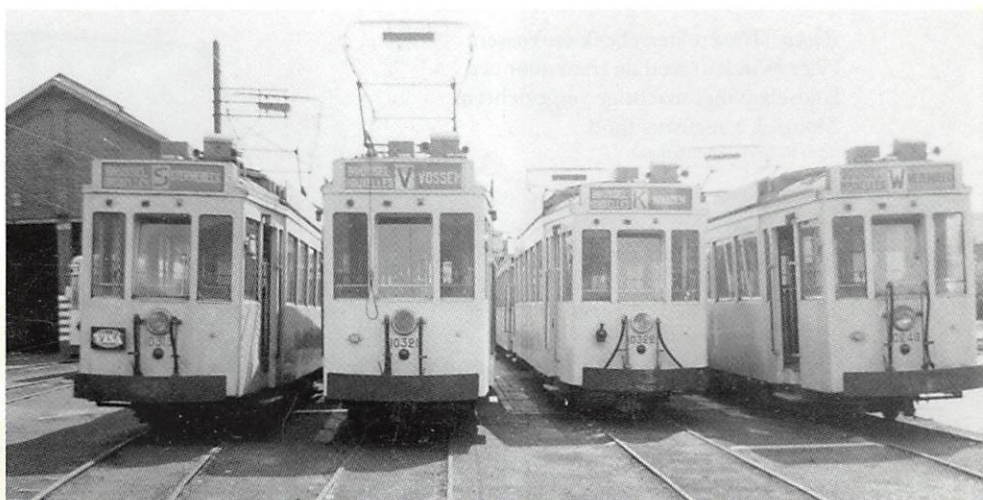
Schaarbeek, Daillyplein. Hier ontmoet een tram van lijn B uit Leuven de Brusselse stadslijn 60. Bemerkt de wissel en het derde spoor dat gebruikt werd door de stoomtrams en spoorauto's vanuit Geldenaken of Tienen (via Hamme-Mille en Vossem) 24 juli 1960. (foto Robert Temmerman)
