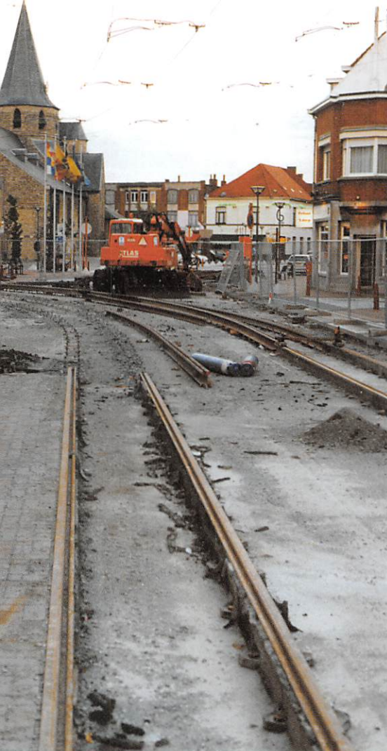
Waar de kaarsrechte weg uit Antwerpen een eerste bocht maakt in Zwijndrecht botsten de nieuwe tramsporen op een woning. Om de lijn door het park, rechts op de foto, te kunnen leiden, diende dit huis te worden afgebroken. Ook de klinkers op de voorgrond was geen lang leven beschoren: kijkt u even naar de foto's links en rechts. 20 september 1999. (foto Alain Janmart)
