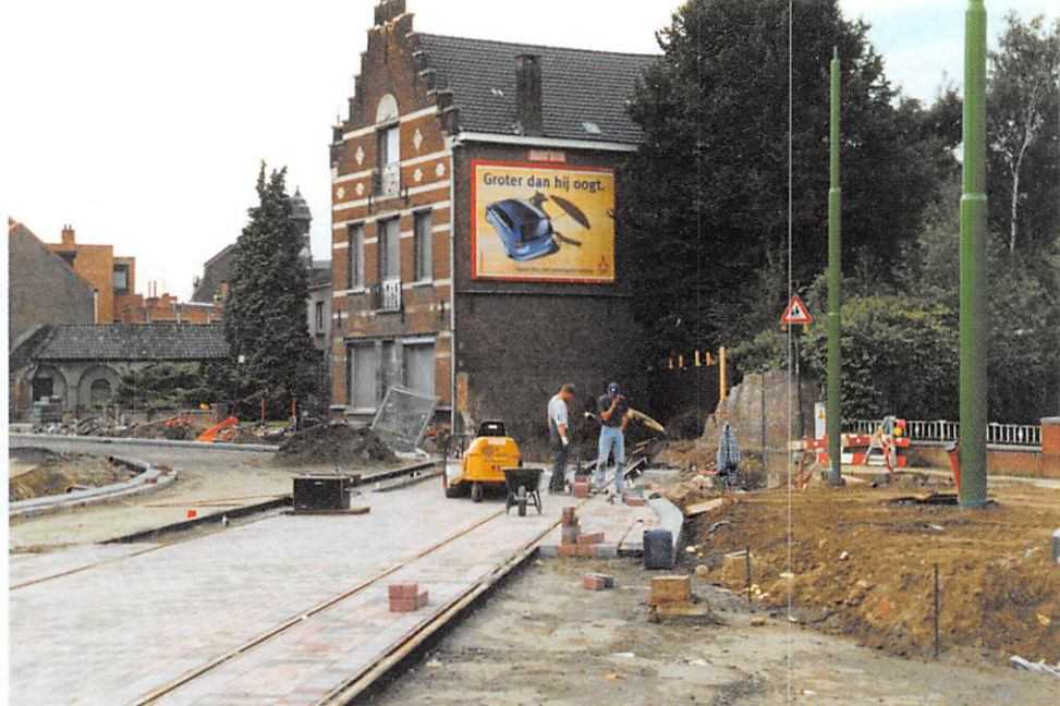
Waar de kaarsrechte weg uit Antwerpen een eerste bocht maakt in Zwijndrecht botsten de nieuwe tramsporen op een woning. Om de lijn door het park, rechts op de foto, te kunnen leiden, diende dit huis te worden afgebroken. Ook de klinkers op de voorgrond was geen lang leven beschoren: kijkt u even naar de foto's links en rechts. 20 september 1999. (foto Alain Janmart)
