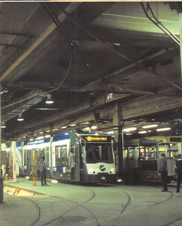
MIVB-Werkplaats Kuregem, 4 februari 2002. (foto Marc Grieten)
