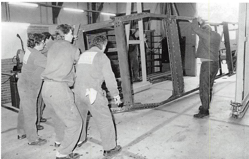
In april 1995 werd het op zijn kop gebouwde bodemframe van GETA 76 gedraaid, waarna de bouw van de wagenbak kon beginnen.
