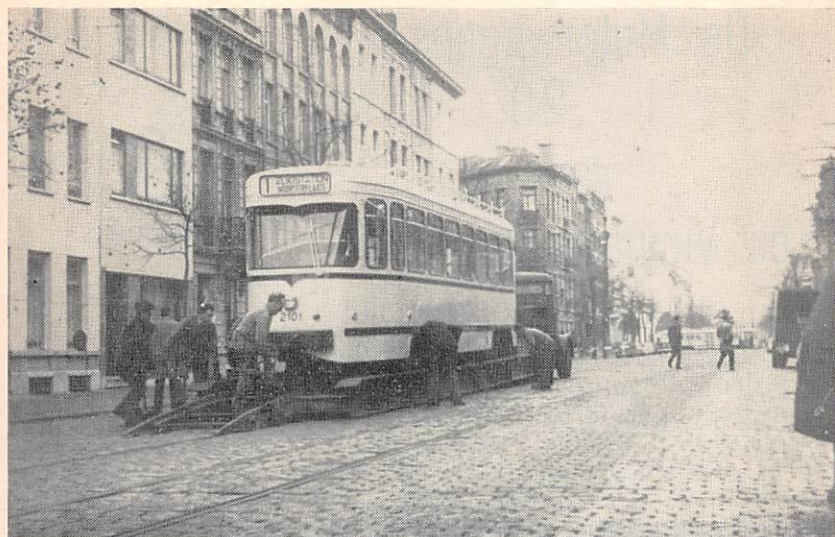
AFLADEN PCC 2101 IN DE EMIEL BANNINGSSTRAAT
