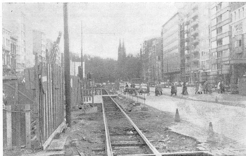
FRANKRIJKLEI ; 1 NOVEMBER 1970 ; ZICHT RICHTING ZUID, AANLEG VAN HULPSPOOR VOOR DE TRAMS KOMENDE VAN HET ZUID. DIT SPOOR LIGT BIJNA IN DE AS VAN DE FRANKRIJKLEI.
