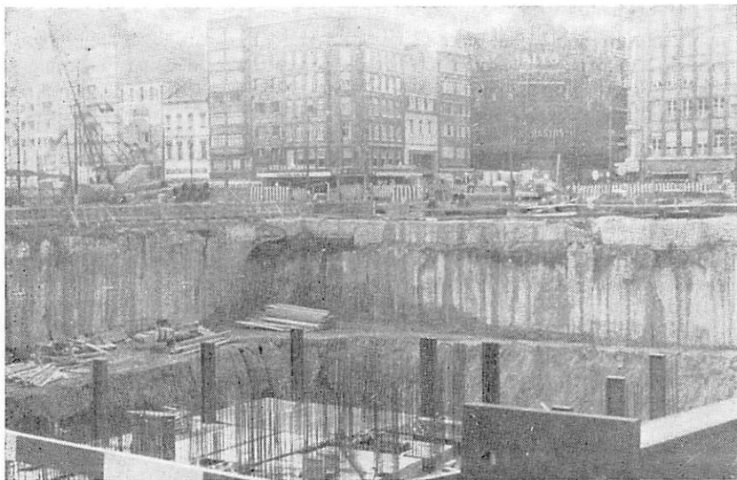
BOUWPUT ANTWERP-TOWER ; IN DE ACHTERGROND, LINKS EN RECHTS DE SLIBWANDEN STATION TENIERS-OPERA. TOESTAND : 1 NOVEMBER 1970.
