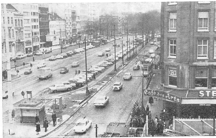
FRANKRIJKLEI, ZICHT RICHTING ZUID, LINKS HET IN NORMALE OMSTANDIGHEDEN GEBRUIKTE SPOOR. RECHTS LANGSHEEN HET VOETPAD HET NIEUW AANGELEGDE HULPSPOOR - 9 APRIL 1970.
