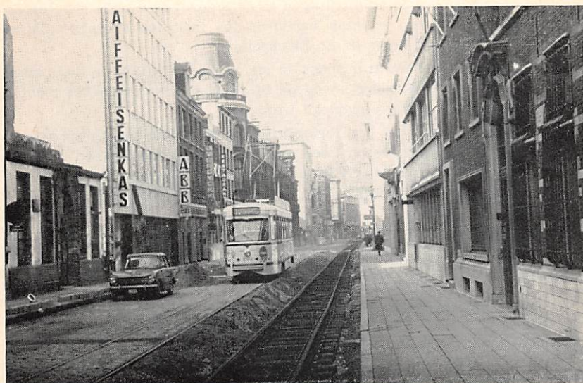
LANGE NIEUWSTRAAT. — RECHTS AANLEG VAN HET NIEUWE SPOOR. TOESTAND OP 2.10.1971. PCC 2102 RIJDT NOG OP HET OUDE SPOOR. Foto v.d. schrijver
