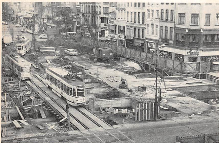
ANTWERPEN. — WERF DE KEYSERLEI - TOESTAND OP 15.10.1971. RECHTS EEN GEDEELTE VAN DE AFGEWERKTE DAKPLAAT STATION TENIERS/OPERA.
