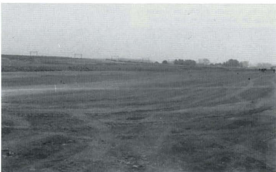
La base travaux de St-Druon est presque achevée. Les premiers rails viendront la garnir au début du mois de novembre. Une vue des plateaux, établis sur plusieurs étages. 20 octobre 1994. Photo : B. DIEU.
