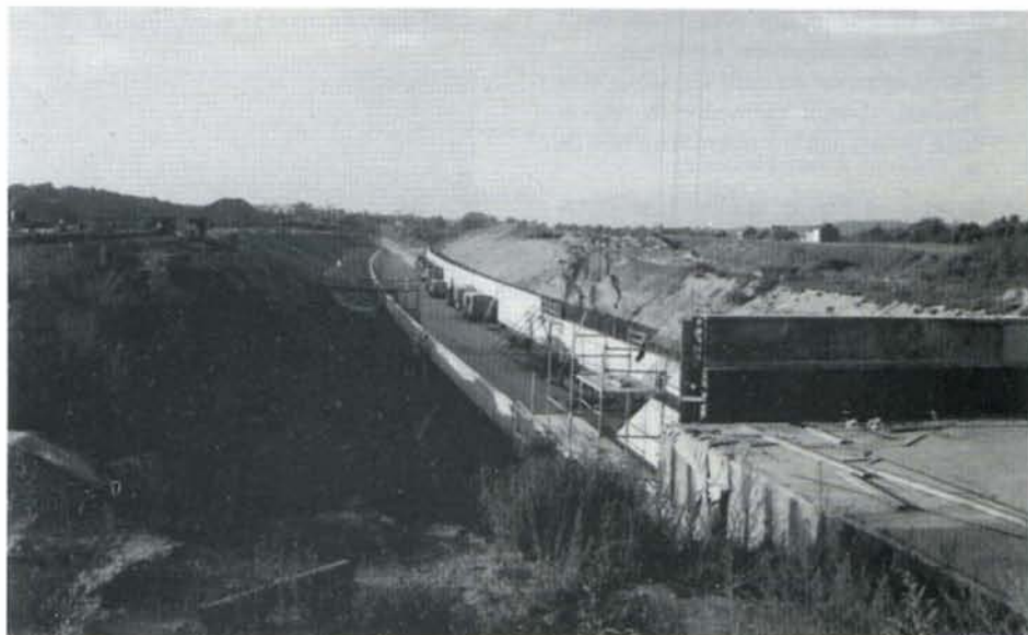
Entre Bruxelles et Liège, seuls les travaux du tunnel de Bierbeek sont commencés. Le tunnel permettra à la ligne TGV en provenance de Louvain de passer sous l'autoroute E40 et ensuite de la longer en direction de Liège. Cette photographie est prise en direction de Louvain, l'autoroute étant située à l'opposé. 18 octobre 1994.
