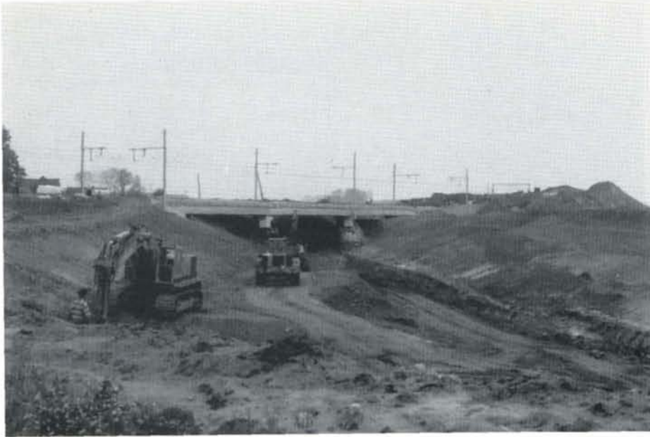
← Prise du PX112, ouvrage sous lequel passe la ligne TGV, vue vers Ath. Dans le fond, les terrassements sont terminés. Le permis de bâtir du tronçon Antoing-Ath n'est pas encore délivré. 20 octobre 1994. Photo : B. DIEU.
