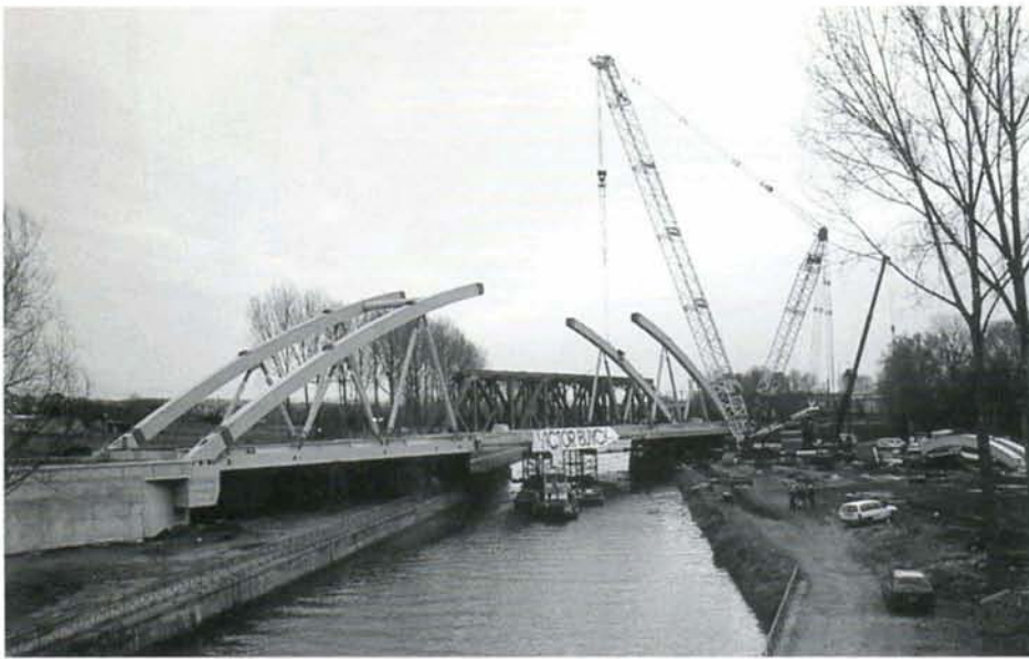
Construction du nouveau pont métallique sur le canal Bruxelles-Charleroi à Halle le 10 décembre. La barge occupe toute la largeur du canal. Photo: Christian DOSOGNE.
