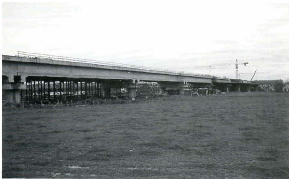
Le viaduc d'Arbre, en train de s'élaner vers Antoing. 26 janvier 1995. Photo : B. DIEU.
