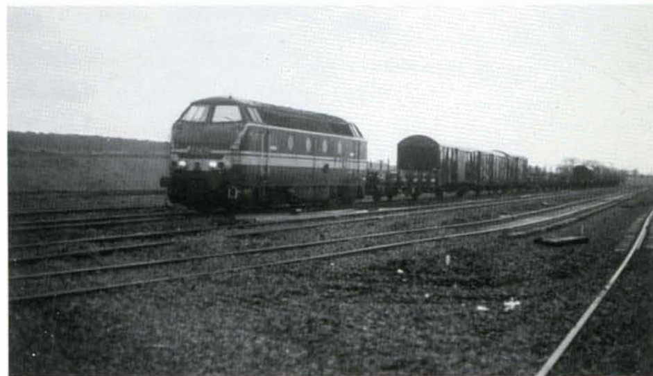
Depuis le 7 novembre, un train régulier approvisionne la base en matériaux de construction. La photo est prise sur les voies du futur faisceau d'échange. Antoing, base de St-Druon, 26 janvier 1995.
