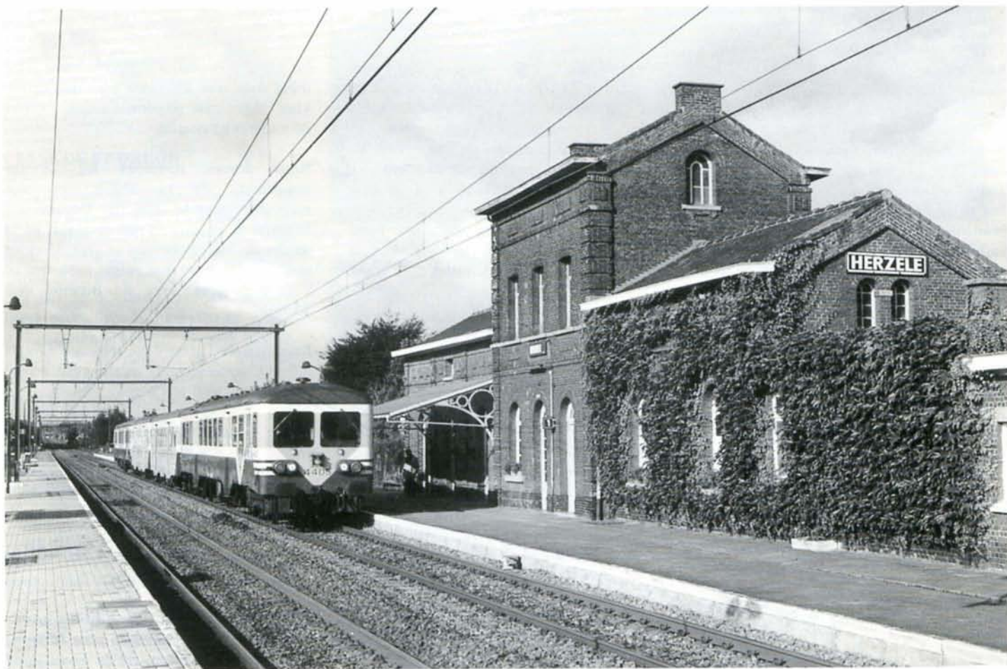
PHOTO 21-02 Un arrêt fut marqué en gare de Herzele sur la ligne 89, dont les abords ont été complètement réaménagés (abris, parking, quais,...). Un très bel exemple d'une modernisation harmonisant le charme de la gare d'antan et les impératifs de confort actuel pour les usagers.
