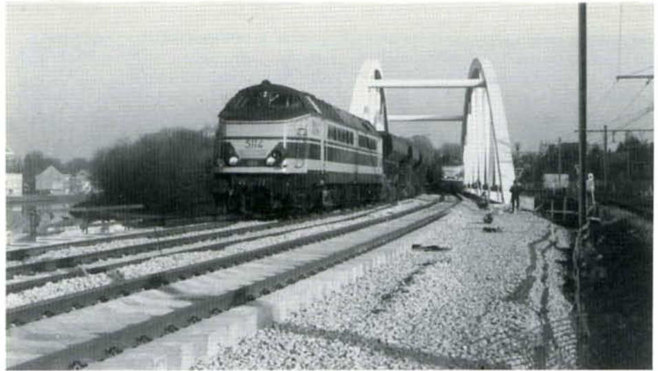
PHOTO 21-39 Essai de résistance du nouveau pont de la ligne 94 à Halle enjambant le canal Bruxelles-Charleroi. Deux locomotives série 51 (5114 et 5103) de Schaerbeek, remorquant chacune quatre trémies de ballast chargées, ont été nécessaires. 29-11-1994. Photo : Jean-Luc VANDERHAEGEN.
