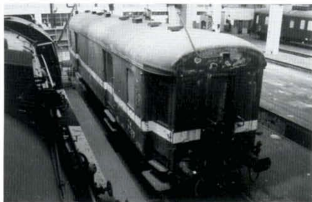
Les premiers travaux de restauration de la voiture Expo-Shop, 17-11-1994.
