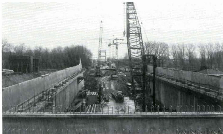
Une tranchée couverte traverse le village de Bruyelle. Les poutrelles sont en cours de pose; dans le fond, le viaduc sur l'Escaut. Bruyelle, 26 janvier 1995.
