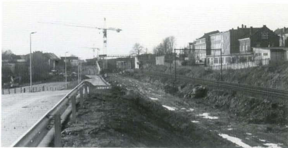
PHOTO 21-40 Vue prise entre le canal Bruxelles-Charleroi et la gare de Lembeek. Les deux voies TGV longeront les deux voies de la ligne 96. Le passage supérieur au fond de la photo est en cours de remplacement. Lembeek, 9-12-1994. Photo J-L VANDERHAEGEN.
