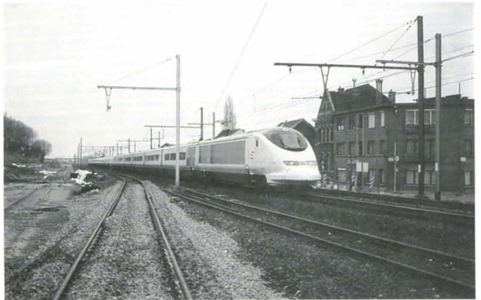
Passage de l'Eurostar 9124 Londres-Bruxelles à Lot, à l'endroit où les deux futures voies TGV s'inséreront entre les deux voies de la ligne 96. A gauche, on prépare l'assiette de la future voie B de la ligne 96 et on distingue nettement le raccord provisoire qui permet aux trains de route de gagner la voie déjà posée. Lot, 17 décembre 1994. Photo : C. DOSOGNE.
