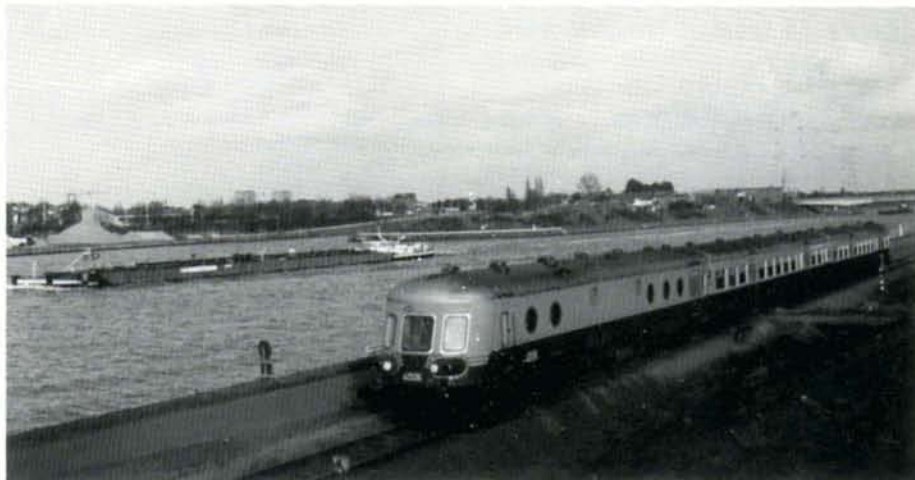
PHOTO 22-21 Au départ d'Herentals, la ligne industrielle 207 longe jusqu'à Zittaart le canal Albert. Le 4006 est photographié sous le soleil couchant non loin d'Herentals. Photo : Jean-Luc VANDERHAEGEN.
