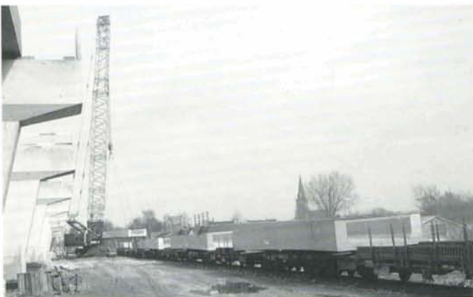
Le 6 février 1995, une grue géante met en place un bac en béton au viaduc de Lembeek. Les wagons stationnent sur une voie provisoire spécialement posée pour ce travail. Photo : Christian Dosogne.
