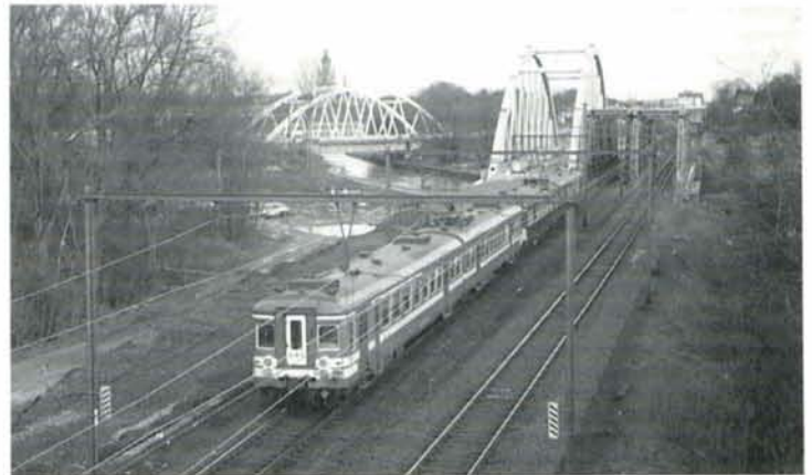
Vue plongeante prise à Lembeek vers Halle. On distingue nettement les 2 nouveaux ponts sur le canal (de biais, ligne 94) et les terrassements en cours le long de la ligne 96. Le pont subsistant fera place à un viaduc identique aux autres mais emprunté par les voies TGV. 30 janvier 1995. Photo : C. DOSOGNE
