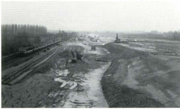
Les travaux à hauteur de la base de maintenance du Coucou, vus vers Halle. A gauche, la ligne 94 Bruxelles-Tournai avec le passage d'un IC Schaerbeek-Mouscron. Meslin l' Evêque, 13 avril 1995. Photo : Baudouin Dieu.
