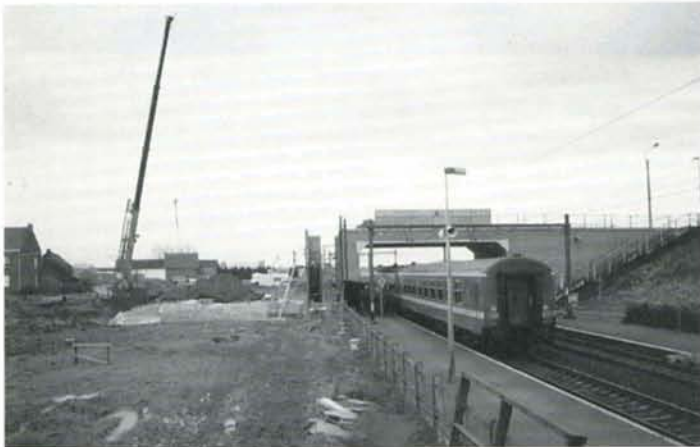
A Silly, le pont de la gare a été démoli en partie pour être élargi. Les travaux vus le 18 janvier dernier. Photo : Christian Dosogne.
