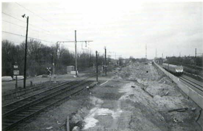
La sortie de la gare de Halle côté Bruxelles. A gauche, la ligne 96A; au centre le futur accès de la ligne 26 vers le viaduc franchissant les voies LGV et la ligne 96. A droite, un IC vers Mons roule à contre-voie. Cette vue appartient déjà au passé... Halle, 10 janvier 1995. Photo : Christian Dosogne.
