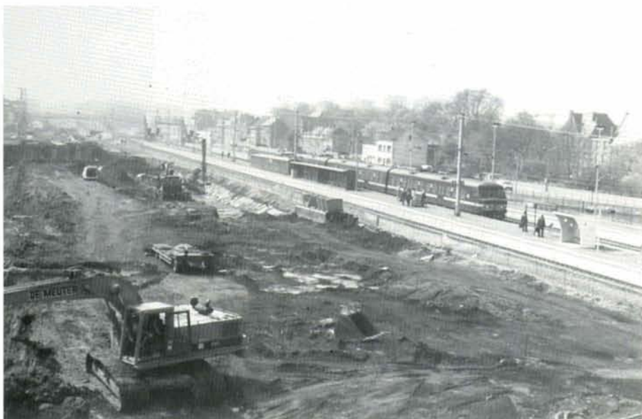
↗ PHOTO DU MILIEU La gare de Halle en chantier. A gauche, la gare provisoire qui comporte trois voies. Au centre, on distingue nettement la dalle de couverture de la future gare souterraine, coulée avant la pose des voies provisoires. A droite, l'ancienne gare a fait place aux engins de génie civil. Halle, 11 avril 1995.
