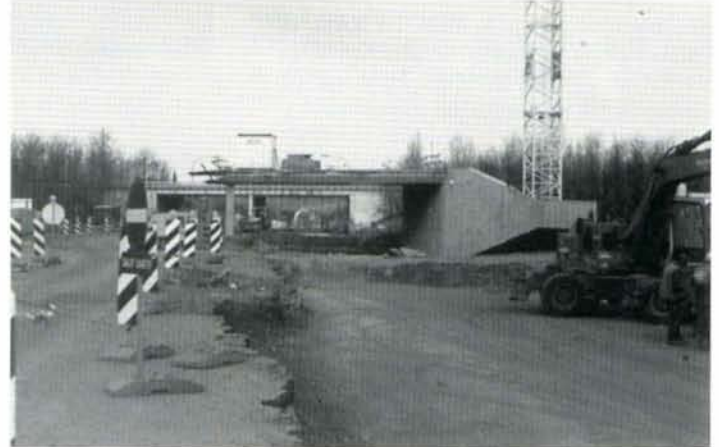
Construction du pont de la LGV sur la route N7-Rebecq. Dans le fond, le pont de l'autoroute. Wisbecq, 13 avril 1995. Ph. : B. Dieu.
