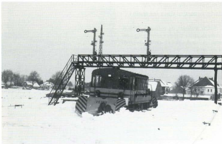
PHOTO-THEME 13 Comment qualifier la démolition de l'extraordinaire passerelle de Sourbrodt? N'y aurait-il vraiment pas eu moyen de la sauvegarder comme témoin du passé? Ici, la 8406 munie d'un éperon chasse-neige évolue sous ce monument unique, le 9 mars 1988. Photo : Jean-Luc VANDERHAEGEN.
