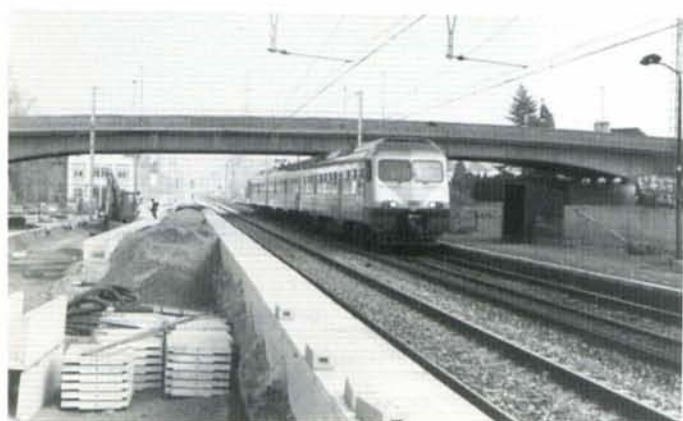
A Buizingen, vue en direction de Bruxelles au passage d'un train IC Schaerbeek-St-Ghislain. La voie de la ligne 96A, à gauche, est en cours de renouvellement, tandis que se construit le nouveau quai. Le passage supérieur ne subira aucune modification. Buizingen, 11 avril 1995. Photo : Baudouin Dieu.
