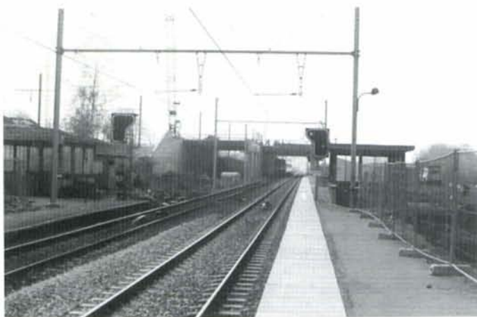
Photo prise en gare de Buizingen vers Halle. Dans le fond, le viaduc permettant à la ligne 26 de franchir les deux voies TGV (à gauche) et les deux voies de la ligne 96. A l'avant-plan, le nouveau quai est aménagé. Buizingen, 11 avril 1995. Photo : Baudouin Dieu.
