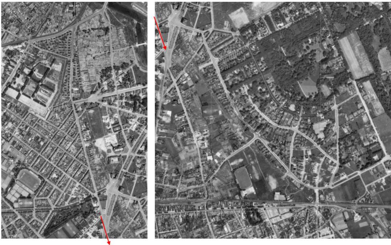
Luchtfoto's van eind jaren veertig waarop gedeelten van de opgebroken lijn van Antwerpen-Zuid naar het spoorwegknooppunt van Wilrijk zichtbaar zijn.
