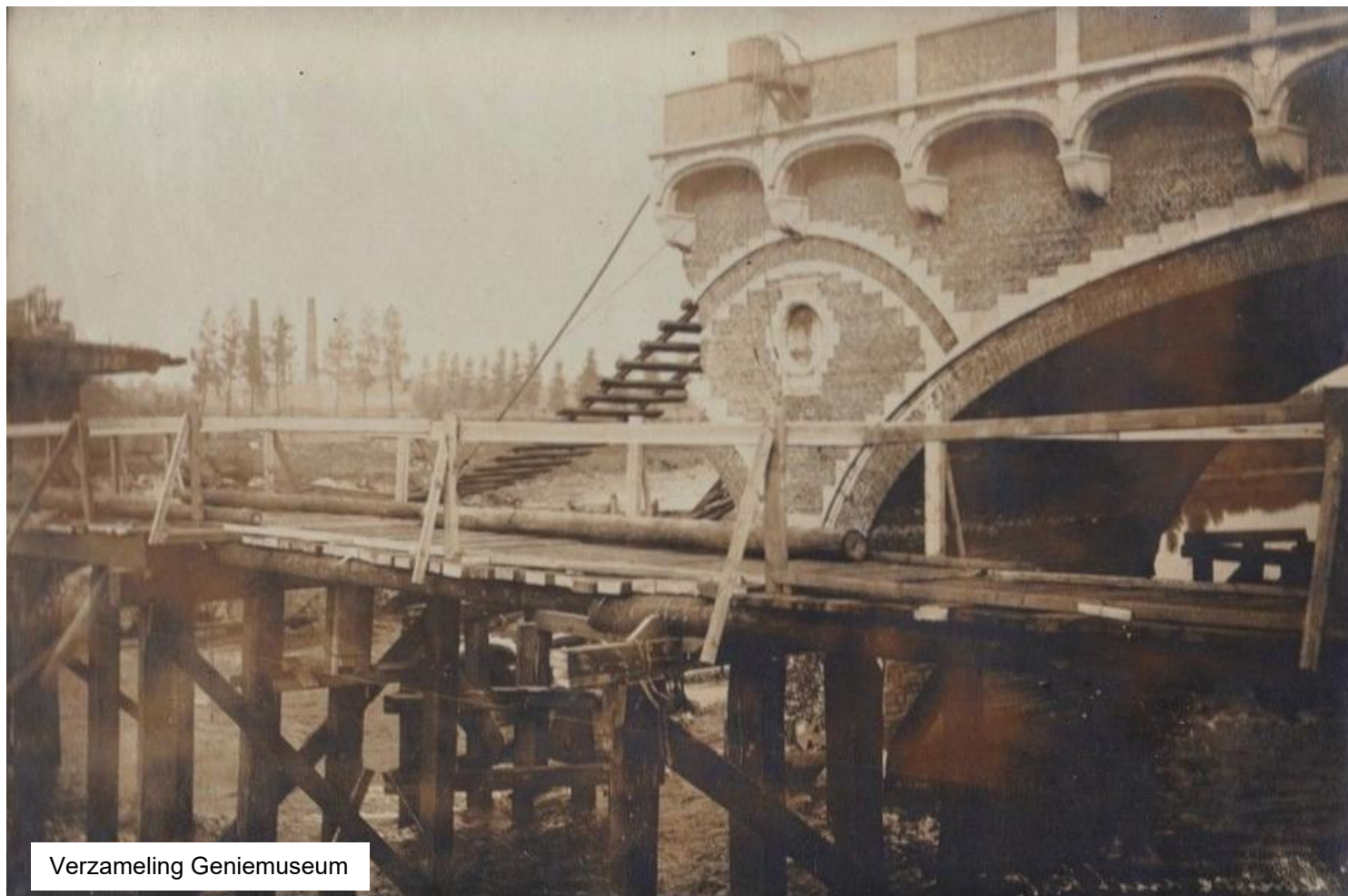
De vernielde brug van de hoofdlijn (lijn 25) over de Nete in Duffel en de houten noodbrug op een later tijdstip. Links richting Antwerpen, rechts richting Mechelen. De eerste boog van de spoorbrug, kant Mechelen, was niet vernield. Op de foto zijn de herstellingen aan de noodbrug (door de Duitsers) duidelijk te zien: het witte hout is nieuw; het zwartgeblakerde hout van de palen is het gevolg van het in brand steken van de brug door de Belgen. Foto: verzameling Geniemuseum.
