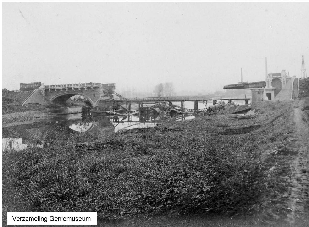
De vernielde brug van de hoofdlijn (lijn 25) over de Nete in Duffel en de houten noodbrug, gezien vanaf de rechteroever van de Nete. Links richting Mechelen, rechts richting Antwerpen. De eerste boog kant Mechelen was niet vernield. Let op het Duitse coupérijtuig (een Pruisische 'Abteilwagen') op de linkeroever van de Nete. Dit rijtuig diende waarschijnlijk als verblijfplaats voor de bewakers van de brug en/of het personeel van MAN Gustavsburg, belast met de voorbereiding van de tijdelijke herstelling van de spoorbrug. Foto: verzameling Geniemuseum.
