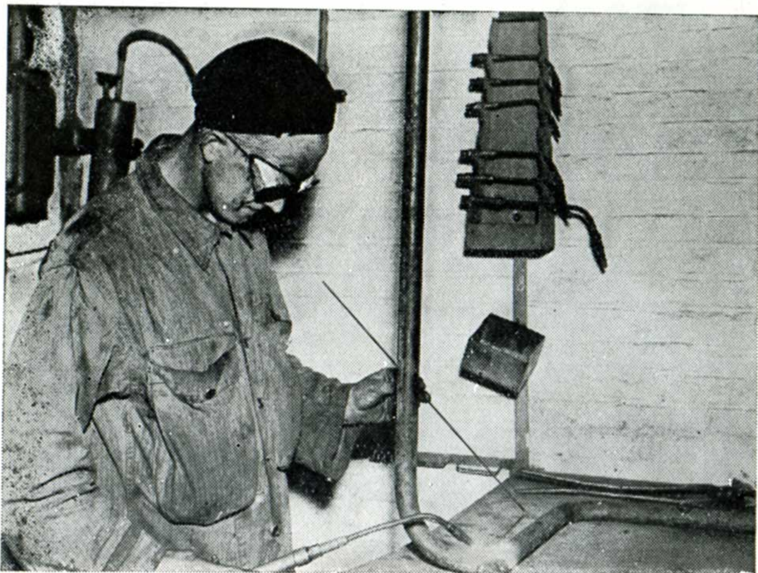
Soudure au chalumeau. — Lunettes de protection.
