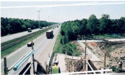
De werken voor de aanleg van de hsl tussen Antwerpen en de Nederlandse grens zijn in oktober 2000 gestart. Eind 2005 zal de nieuwe spoorlijn voltooid zijn.
