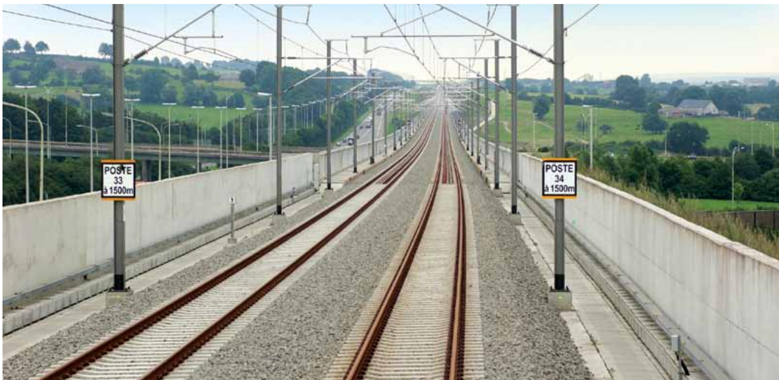
Croisement des lignes 53 et 54 à hauteur de 't Heike Pont Vierendeel sur la ligne 73 à Grammene Le viaduc de Battice sur la ligne à grande vitesse L3
