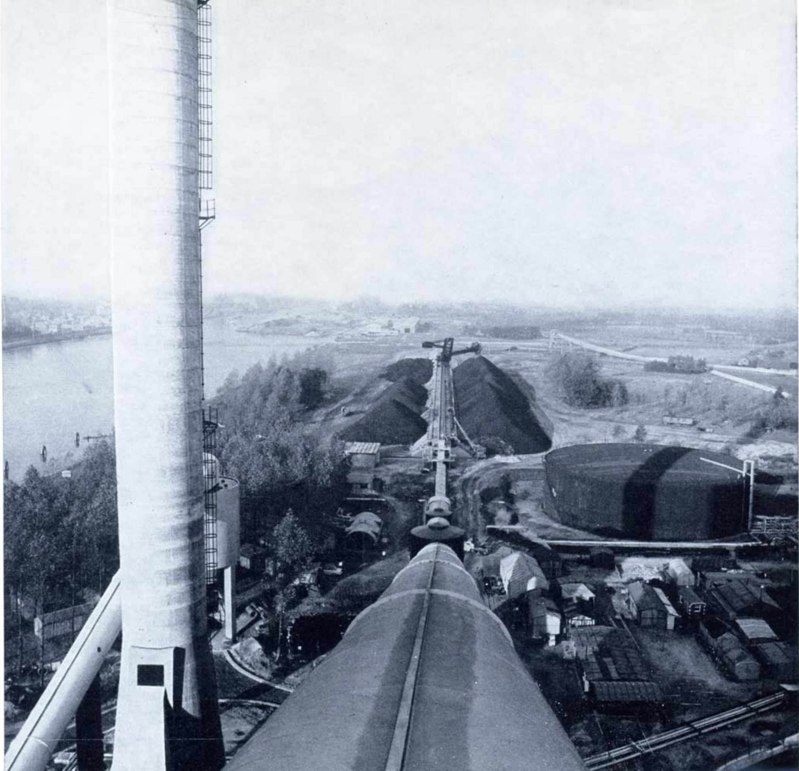
Vue du parc à charbon actuel. Au stade final, il sera complété, sur la droite, par une deuxième bande transporteuse avec roue pelleuse-jeteuse. La capacité atteindra alors 600.000 tonnes.
