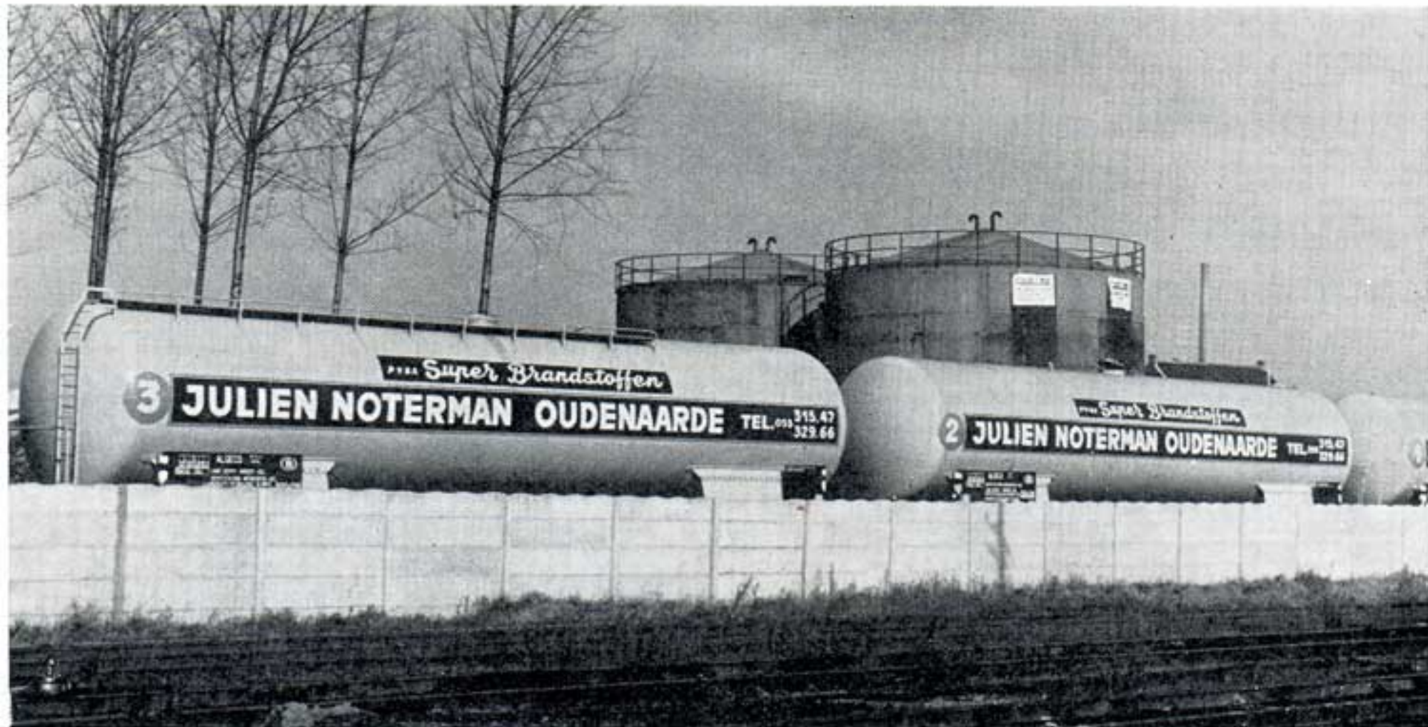
Rame de wagons-citernes dans les installations de la firme Noterman à Audenarde.
