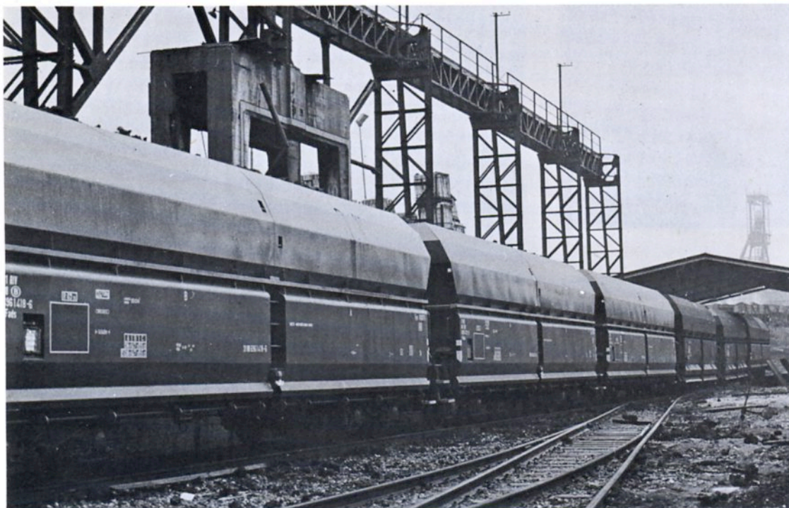
Le train pénètre dans l'installation, sur la fosse...
