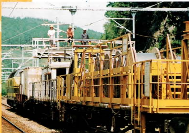
Elektrificatiewerken op de lijn 42 Rivage-Gouvy.
