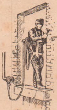
Sicherung mit Fallgurt
