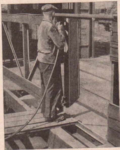
Diese Rüstbretter geben ihm einen sicheren Stand!
