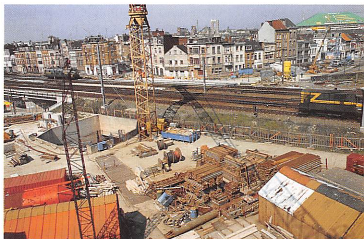
Werf Schijnpoort: uiterst links de nieuwe spoorwegbrug, in het midden de vertrekschacht voor de schildtunnel, rechts achter de spoorweg de werf Station Schijnpoort — 20.4.1988.
