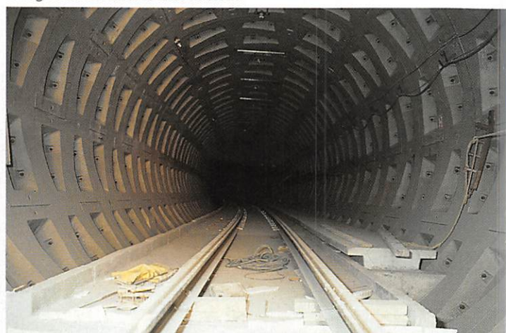
Tunnel Schijnpoort-Stuivenberg — 14.4.1988: wachtend op verdere afwerking; het einde van de budgettaire tunnel is niet in zicht.
