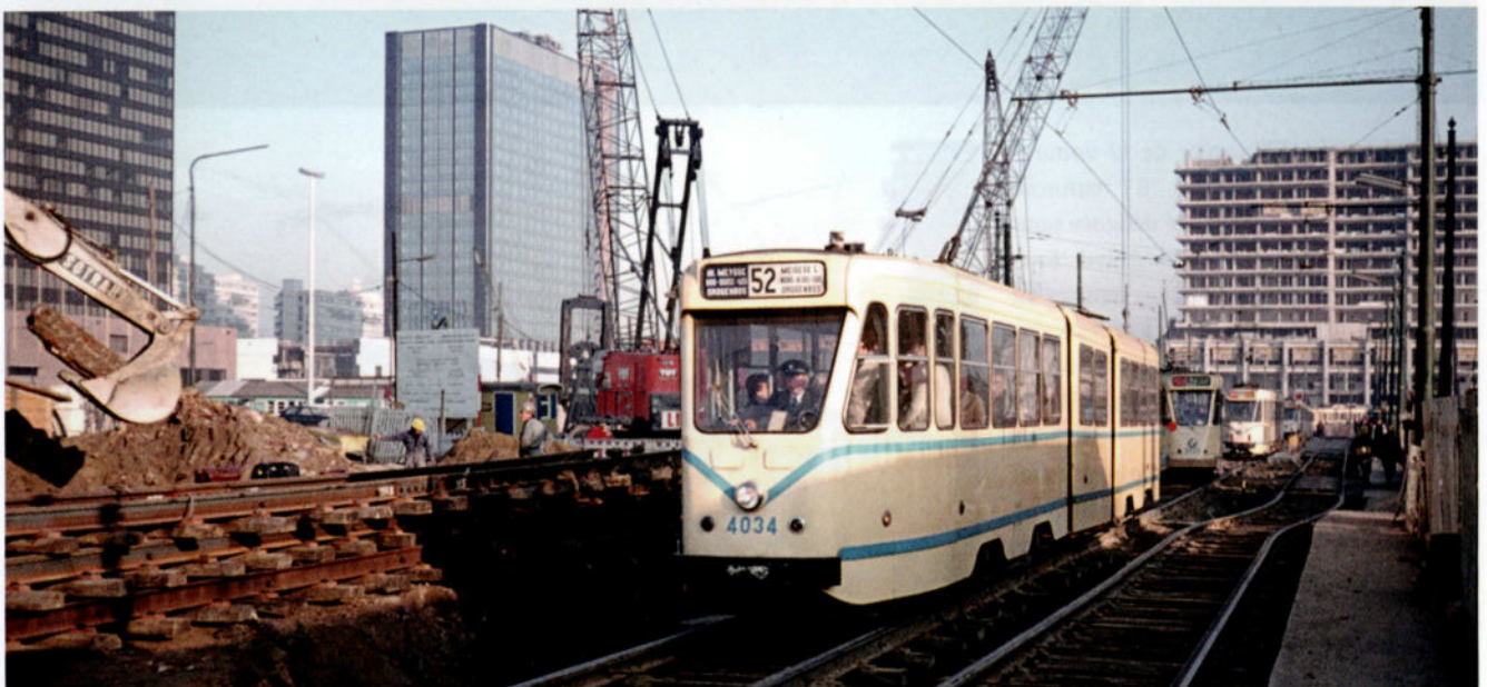
La construction des tunnels du pré-métro de l'axe Nord-Sud bat son plein, en 1975. La 4034 de la ligne 52 vers Drogenbos passe sur les voies provisoires de la rue du Progrès, établies à hauteur de l'ancienne 'esplanade' pour tramways, qui était située devant le bâtiment de la gare du Nord. Elle est suivie par la 9029, qui assure un service sur la ligne 62. A l'arrière-plan, on distingue également une 7800 de la ligne 90 à son terminus de l'époque, dont la disposition justifia à nouveau l'acquisition de motrices bidirectionnelles, après que ce type de matériel ait disparu du réseau urbain de Bruxelles pendant des décennies. Photo: Michel Van Ussel.
