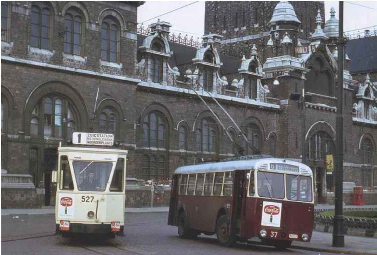
Het stationsgebouw van Antwerpen-Zuid (straatkant), met een tram van lijn 1 (Zuidstation – Noorderplaats) en een trolleybus van lijn 6 (Zuidstation – Borgerhout). De laatste trolleybussen van lijn 6 reden op 30 maart 1964, de laatste trams van lijn 1 op 14 juni 1965.
