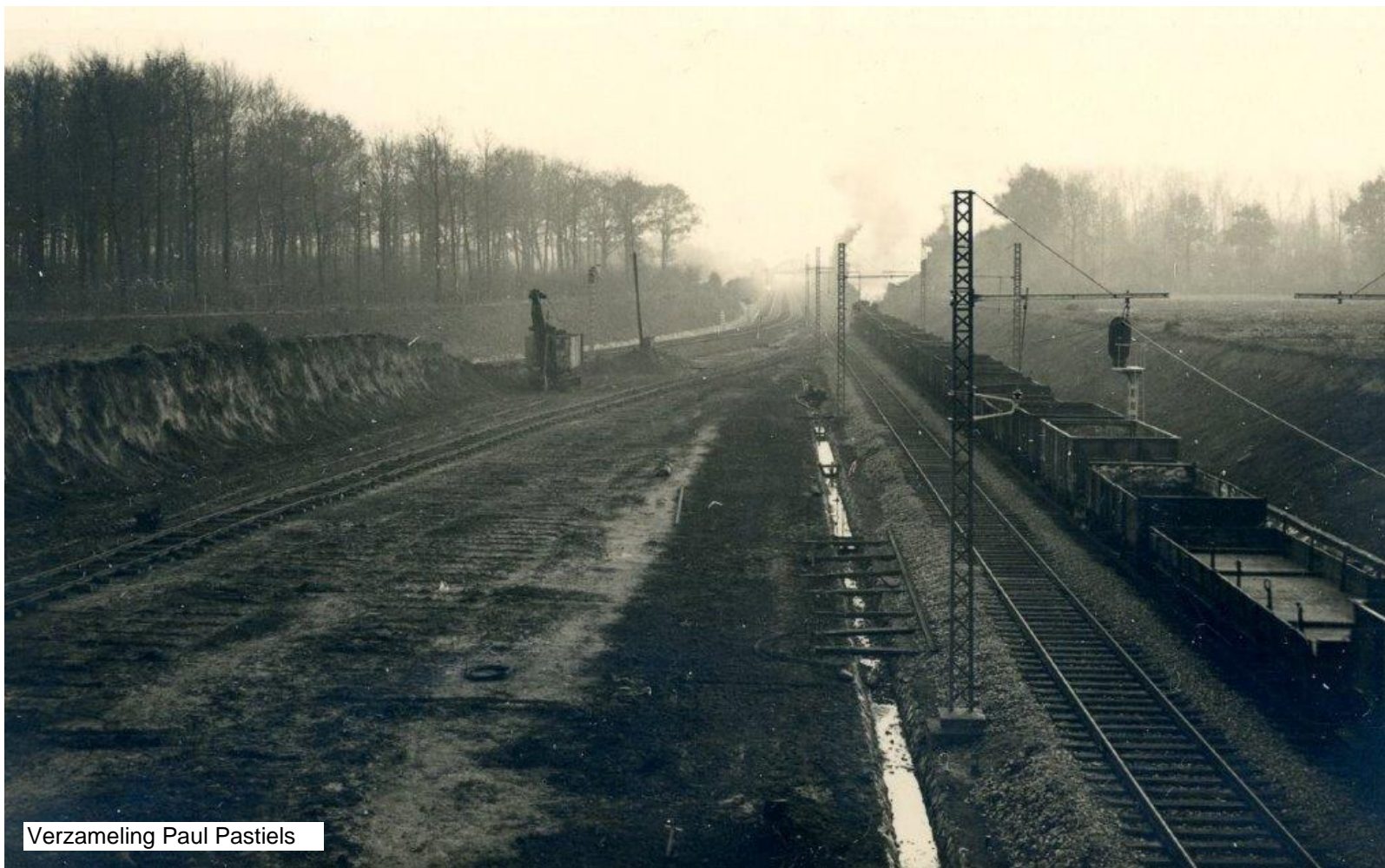
De splitsing van de spoorlijnen aan de grens van de gemeenten Hove en Mortsel, eind 1934 of begin 1935. Rechts lijn 25 met een werftrein en uiterst links de nieuwe 'trage lijn' (de latere lijn 27). De spoorwerkzaamheden bevinden zich in de eindfase; in het midden van de foto is nog een tijdelijk werkspoor zichtbaar. In de verte zie je vaag de betonnen boogbrug van het station Hove. De 'trage lijn' en de nieuwe stopplaats Oude-God aan de Liersesteenweg zijn reeds in dienst. Foto: verzameling Paul Pastiels.
