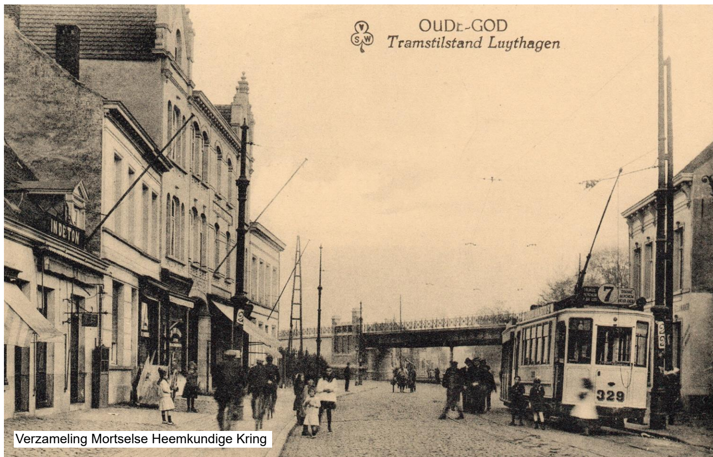
Een foto van de brug over de Antwerpsestraat, genomen richting Oude-God. Tram 7 had hier zijn eindpunt, omdat de tramsporen de gelijkgrondse sporen van de fortenlijn niet mochten kruisen. Na de indienstneming van de spoorbrug werd de tramlijn verlengd tot het Gemeentehuis van Mortsel (Oude-God). Op 23 september 1923 bereikten de trams voor het eerst hun nieuwe eindpunt. Prentbriefkaart: verzameling Mortsele Heemkundige Kring.
