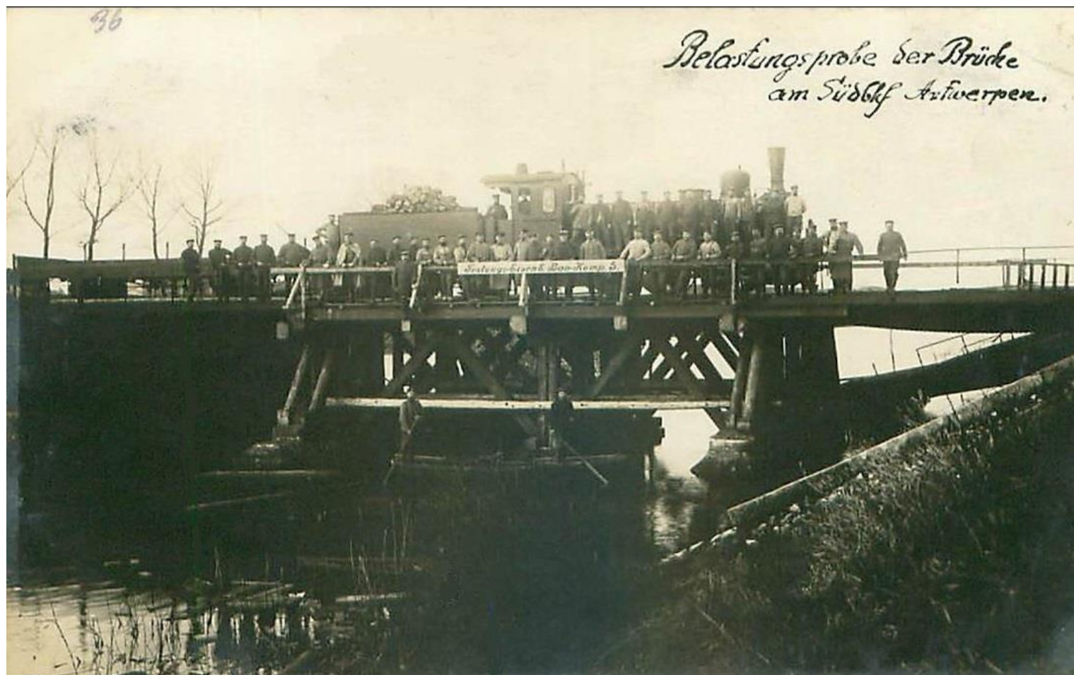
Belastingproef van de voorlopige noodbrug over de vestinggracht te Antwerpen-Zuid kort na de val van Antwerpen. In het artikel in Het Handelsblad op blz. 26 wordt verwezen naar de vernieling van de brug door het Belgisch leger op 8 (?) oktober om 01:00 uur. De noodbrug is gebouwd door de Festungs-Eisenbahn-Bau-Kompagnie Nr.5 (Antwerpen-Süd). De locomotief is een Pruisische G3. Foto: Internet.
