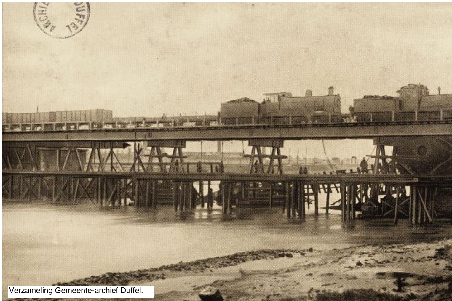
De noodbrug over de Nete op lijn 25 Antwerpen-Centraal – Brussel-Noord). De brug werd gebouwd door MAN-Werk Gustavsburg en in dienst genomen op 4 december 1914. Foto: Gemeente-archief Duffel.
