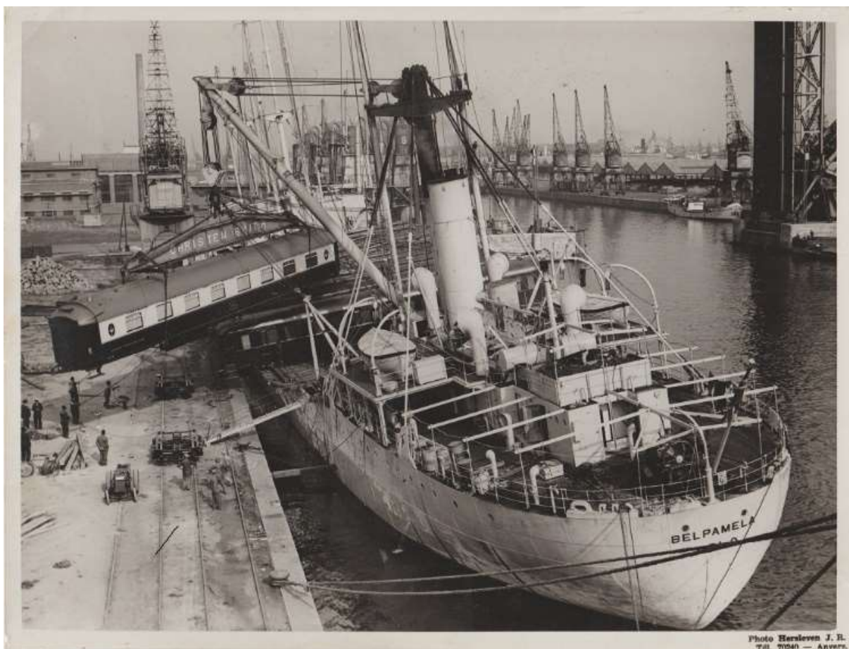
En 1937 la CIWL charge à Anvers sur le Belpamela, la VP 4062 à destination de Hong Kong. La caisse est grutée séparément des bogies par les mats de charge du navire. Collection PY Toussiro
