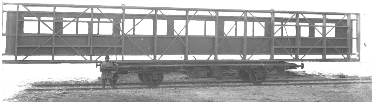
(3) La fiancata lato corridoio poggiate su un telaio montato sopra un carro pianale, probabilmente utilizzato per gli spostamenti all'interno dello stabilimento 22 .
