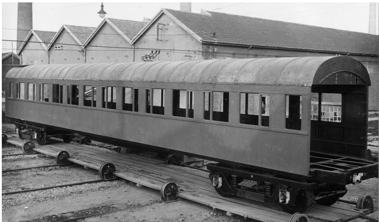
(8) Sul carrello trasbordatore viene fatta scivolare via la carrozza-letti con entrambe le fiancate montate, il tetto e con lo chassis poggiante sui carrelli PP 27 .
