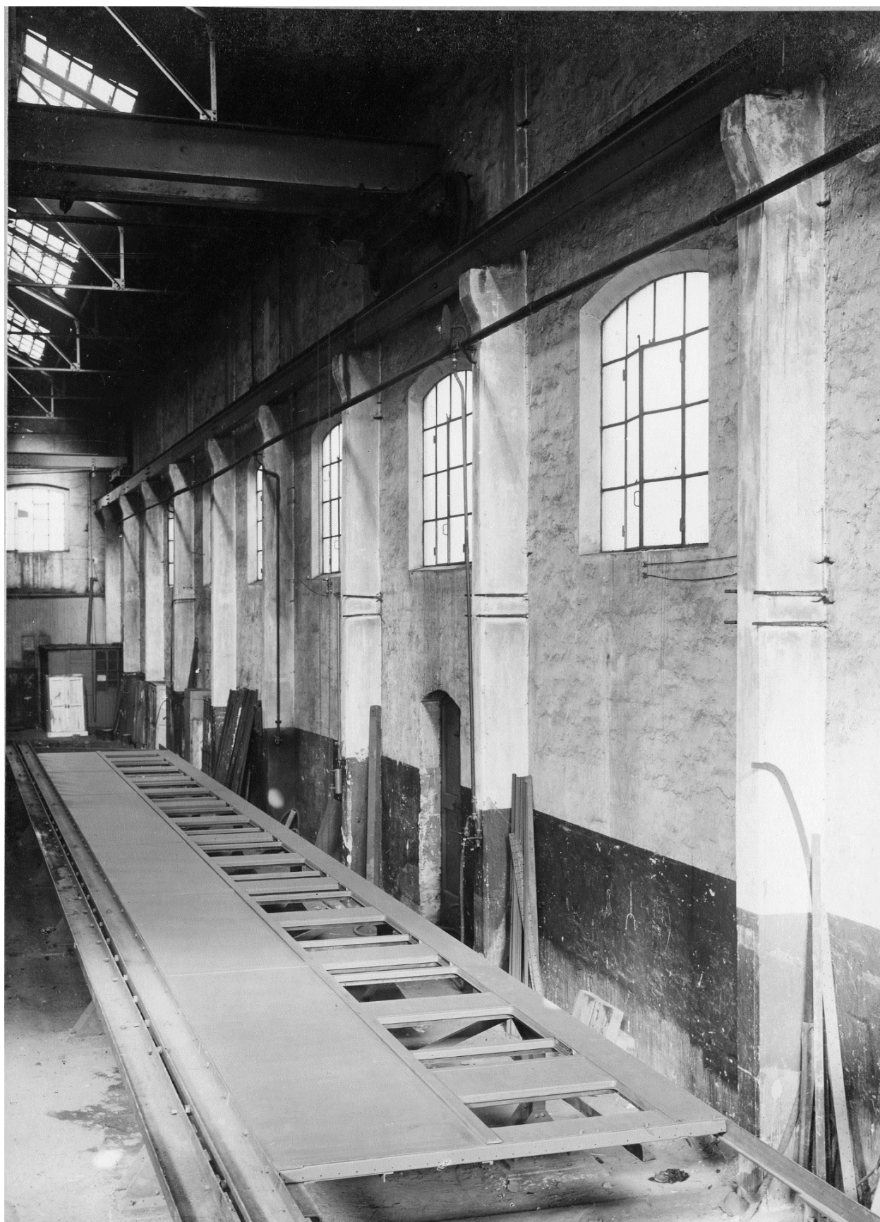
(2) La fiancata lato cabine della carrozza-letti WL Z appoggiata sul telaio 21 .
