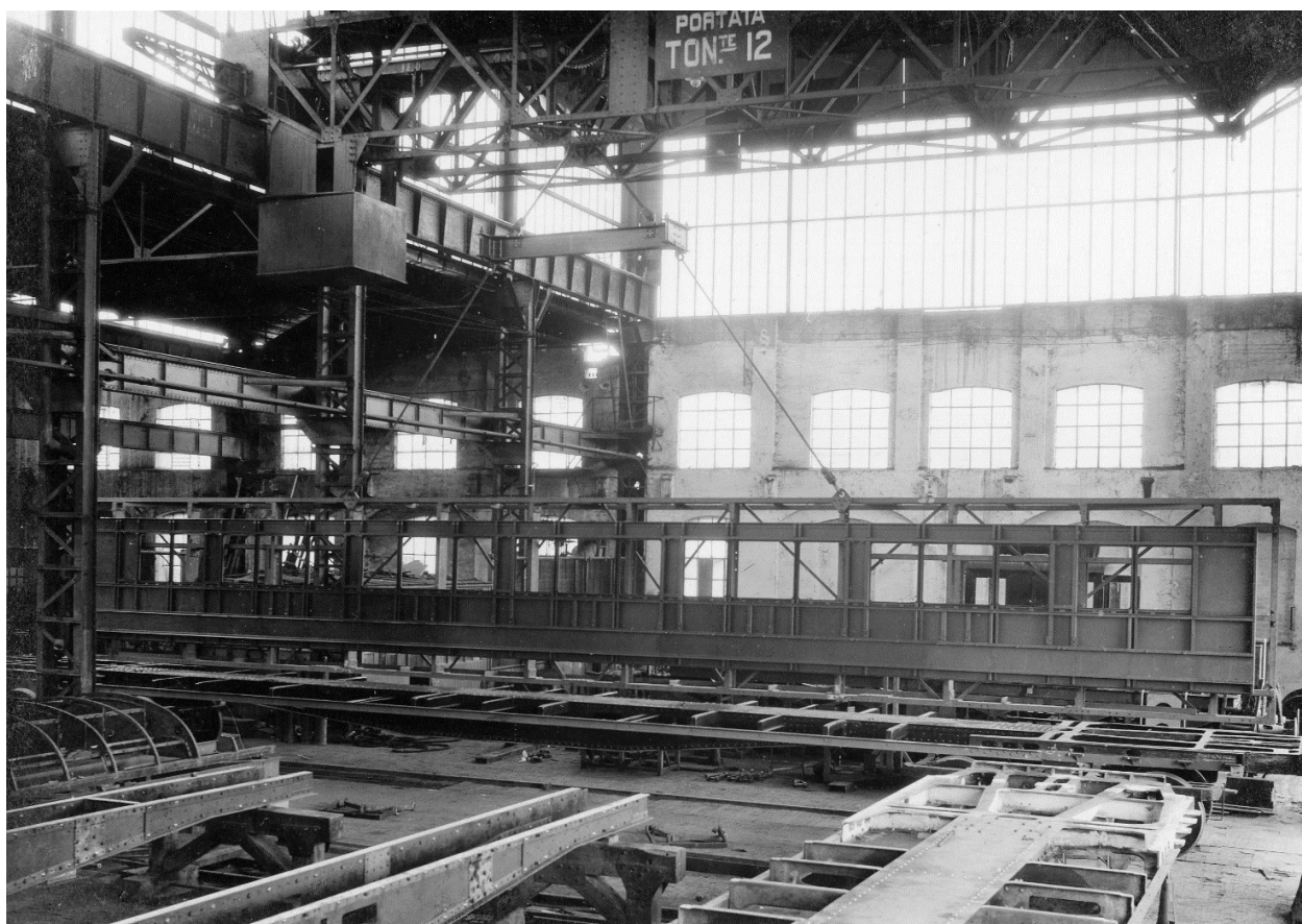
(4) La fiancata lato corridoio viene lentamente montata sullo chassis della carrozza grazie al carro ponte dalla portata di 12 tonnellate 23 .
