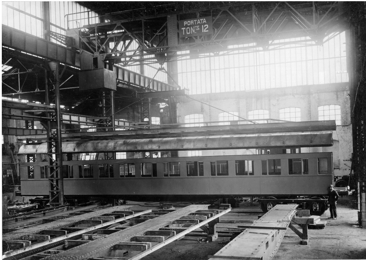
(7) Le fasi di montaggio del tetto a botte della carrozza-letti 26 .
