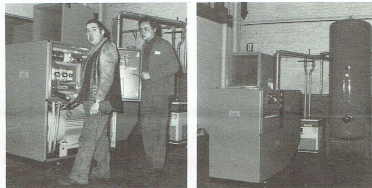
Gilbert Bormans en Luc Giroul installeren de nieuwe compressor. De ingewanden zijn duidelijk zichtbaar. (Foto: Luc Lochtman). Klaar voor het gebruik. Een « luchtig » geheel! (Foto: Luc Lochtman).
